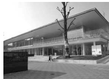
省エネを踏まえた新設建物 (H25年度 美術館)
